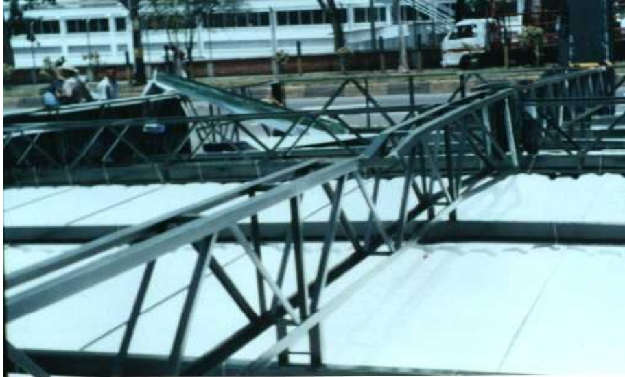
FIGURA 4. Cercha Principal, voladizo girado.
