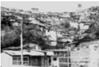
Imagen 3. Construcción en terrenos inestables de fuerte pendiente susceptibles a deslizamiento en el barrio Ventidaderos, Manizales. Fuente: López y López.
