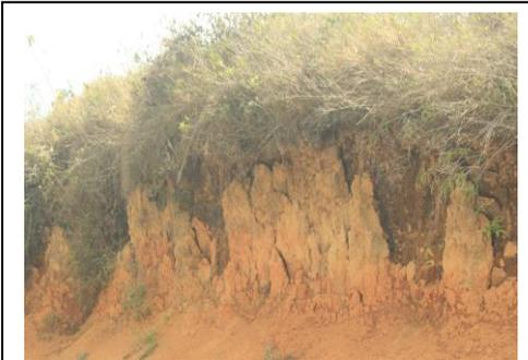
**Figura 6.6** Talud de corte vial conformado por suelo arcilloso que alcanzó humedades por debajo de la deshidratación y del límite de contracción. El talud es inestable porque se formaron estructuras del suelo por la contracción y se desestabiliza por erosión eólica e hídrica; el talud no es una estructura funcional para la vía por ser inestable y por la pérdida de plasticidad del suelo. (Carlos E. Escobar P.).
