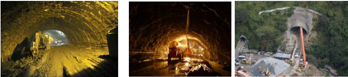
Figura E - 8 Imágenes de la construcción del Túnel II Centenario (Fuente: varias)
