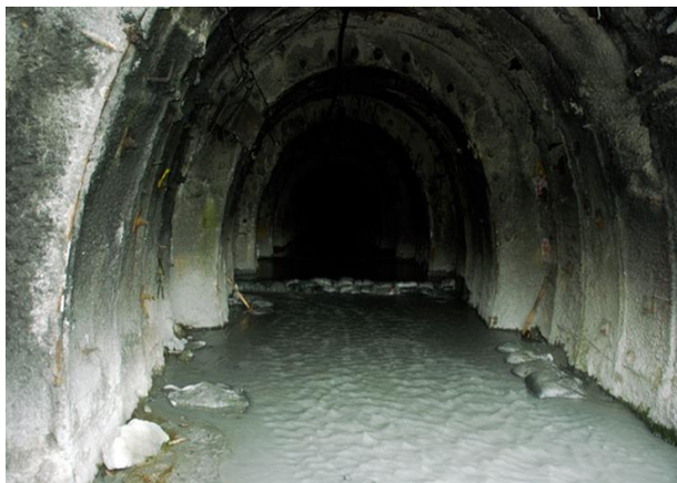
Figura E - 7 Izq. Descargas de agua subterránea del Túnel Piloto, Der. Descargas en la Qda. La Gata
