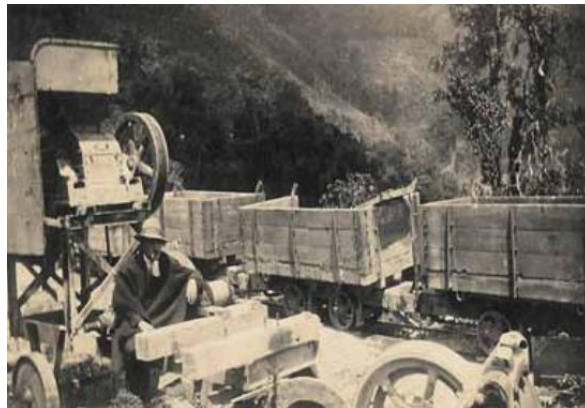
Figura E - 3 Detalles de maquinaria empleada para la excavación del Túnel de La Línea (1934), Tomado de Lopera [2011]
