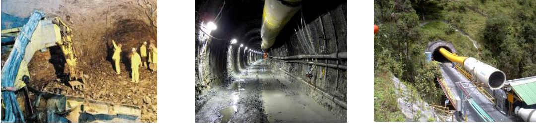
Figura E - 5 Imágenes de la construcción del Túnel Piloto (Fuente: varias)
