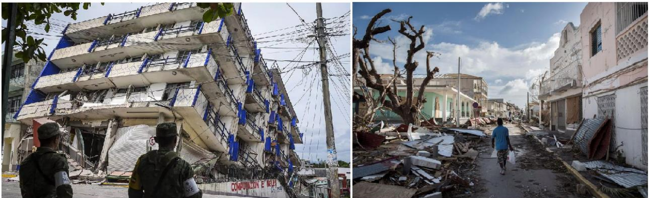
Daños por Sismo en Oaxaca, México; y por Huracán Irma en San Martin, Antillas Menores. Fuente: Nationalgeographic.com
