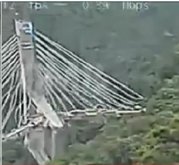
Desplome del pilar occidental del puente Chirajara Publimetro Colombia
