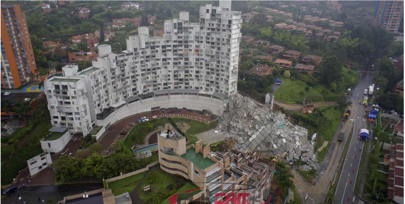
Tragedia en el barrio El Poblado, Medellín: construcción en manos de avilantadas empresas e irresponsables curadores. Fuente: https://esp.habitants.org
