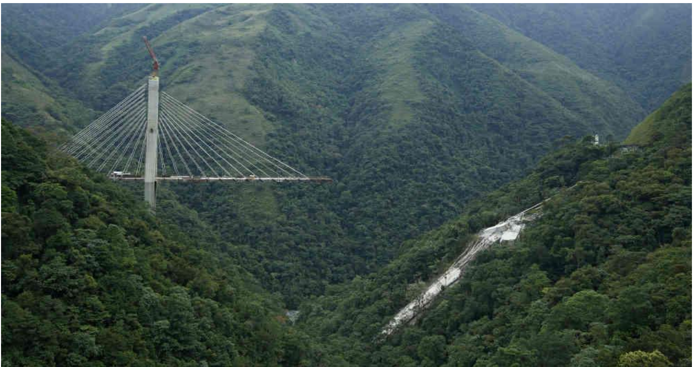
La tragedia del Chirajara afecta la confianza en la revolución en infraestructura que vive el país y retrasa la construcción de una vía estratégica. Fuente: http://www.semana.com
