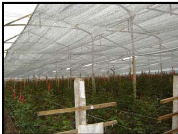
Imagen 3.2: Pantalla térmica extendida horizontalmente
